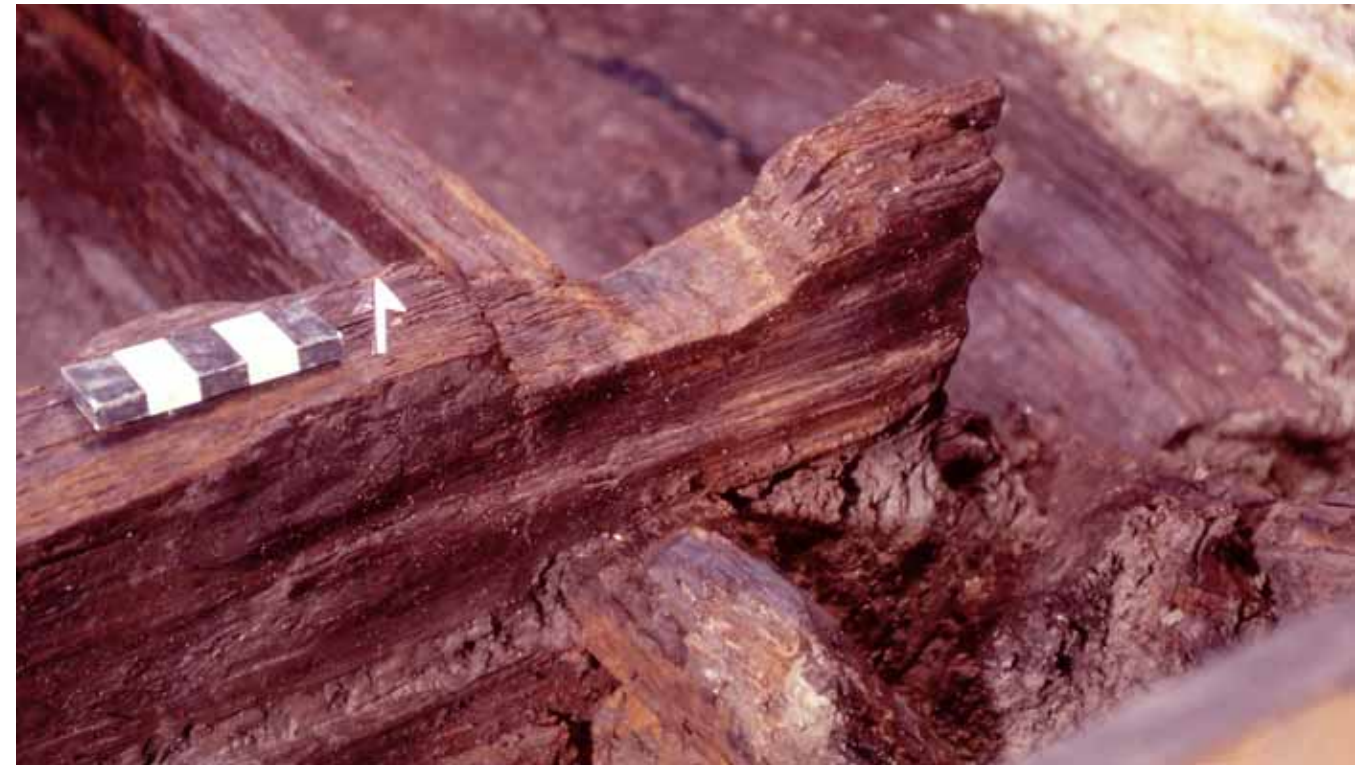
Eckverbindung: bei der Aussparung mit Beleg für die sekundäre Nutzung. Eckverbindung: zur Stabilisierung wurden kleine Ausgleichshölzer eingebaut.
