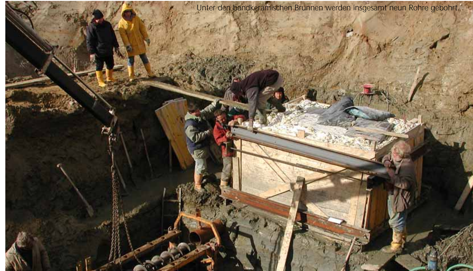
Einbringung von T-Trägern für die Hebung.
